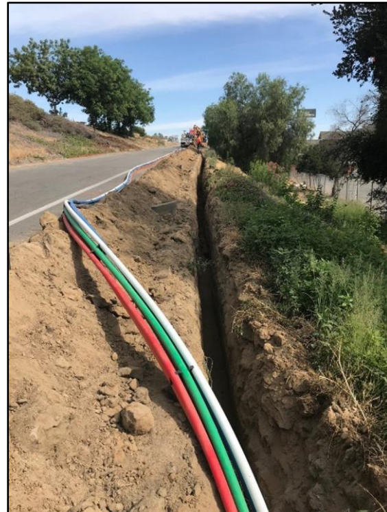
Figure 10. Conduit Placement
