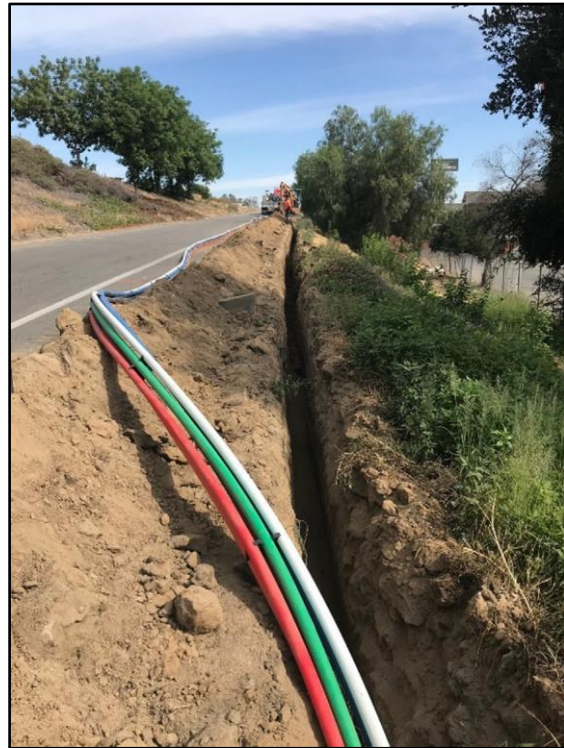
Figure 10. Conduit Placement
